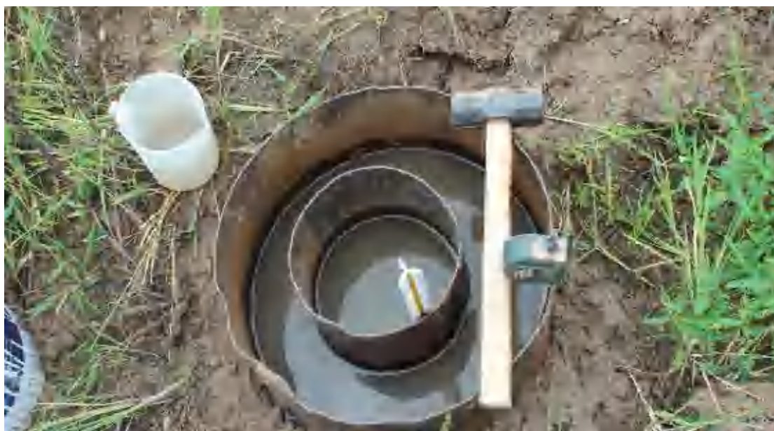
图 6.5-4 渗水试验现场照片
